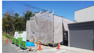
↑市役所西側に建設中の回収ステーション
