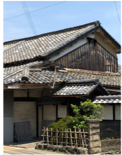
解体前の富永屋→
